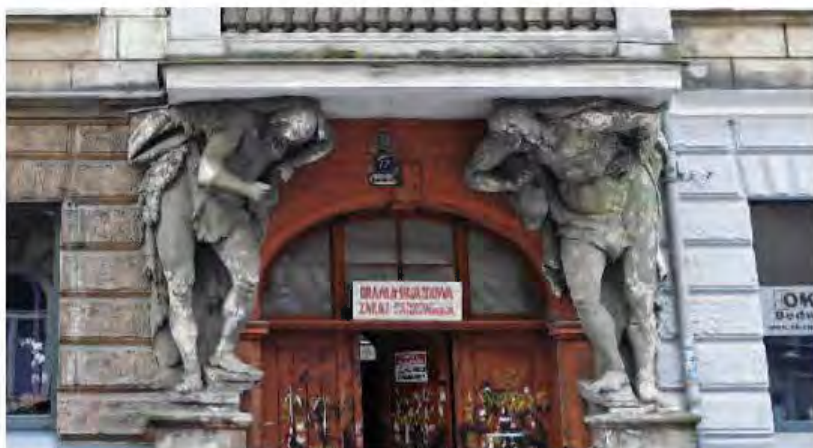
Atlasy na kamienicy przy ulicy Kanatowej
